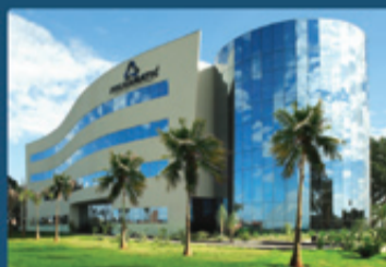
Área construída de 4.200m 2
